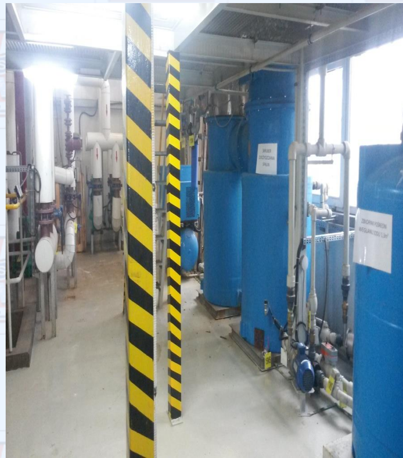
Skruber i kolumna ze złożami fluidalnymi z tworzywa sztucznego.
