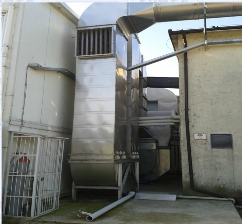
Wymiennik regeneracyjny powietrze-powietrze.
