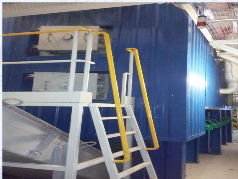
Komora spalania z rusztem taśmowym.
