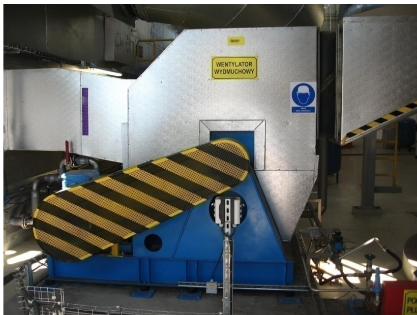
Wentylator powietrza wylotowego (z lewej), skruber do chłodzenia powietrza wylotowego ( z prawej )
