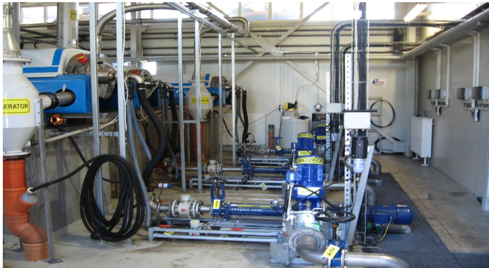
Pompy osadu przefermentowanego i maceratory, wirówki dekantacyjne
