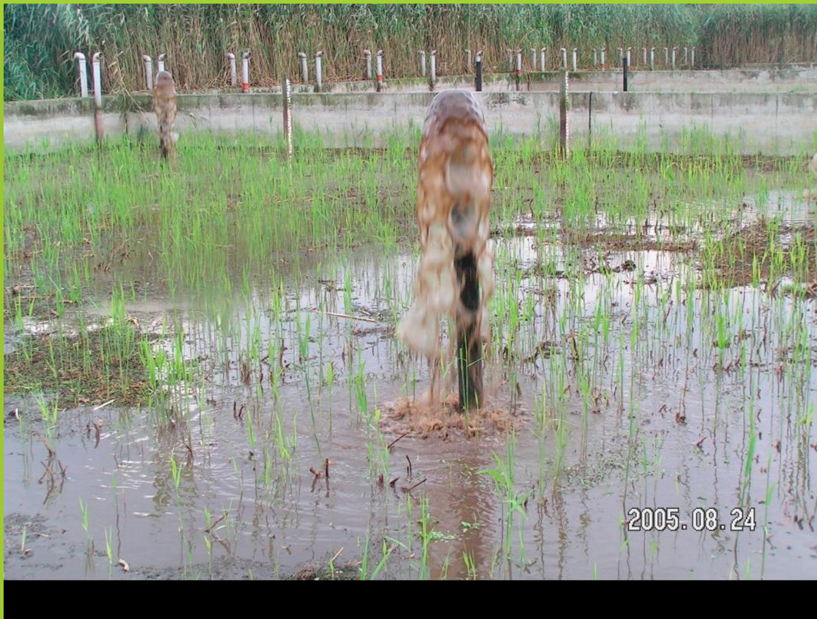
Dostarczanie osadów do systemu trzcinowego (Helsingø)
