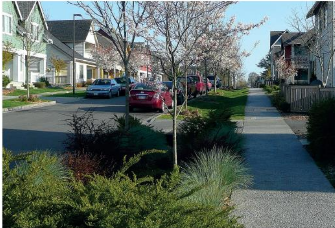
Rys. 3.13. Muldy chłonne obsadzone roślinnością wzdłuż ulicy w dzielnicy domów jednorodzinnych Seattle, USA; źródło: http://upload.wikimedia.org/wikipedia/commons/thumb/8/83/High_Point_Seattle_03.jpg/1024px-High_Point_Seattle_03.jpg
